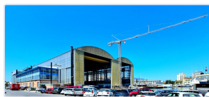
Cantiere navale Benetti a Viareggio: capannoni di costruzione e gru | © Carlo Dani, CC BY-SA 4.0 / Wikimedia Commons
